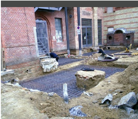
Hofsanierung – vor Haus C, 2007
