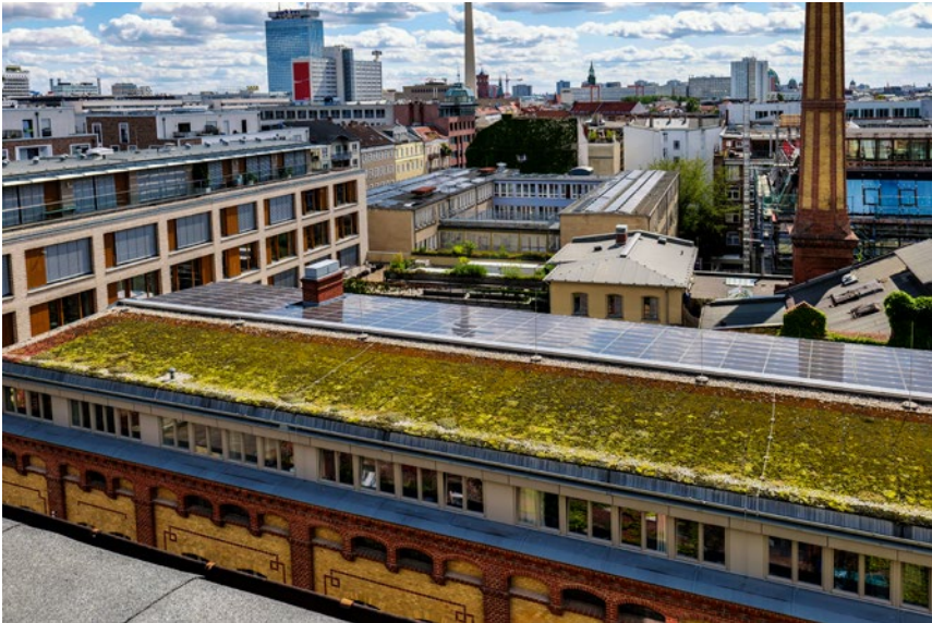
Dachbegrünung und Photovoltaikanlage auf Haus D
