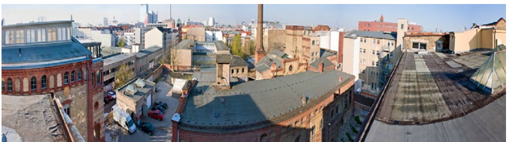
Panoramablick vom Dach Haus C, 2009
