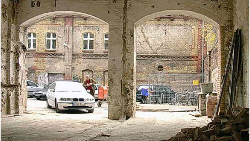
Entkernung der heutigen der Werkstätten von Mario Kwast und Dida Holz
