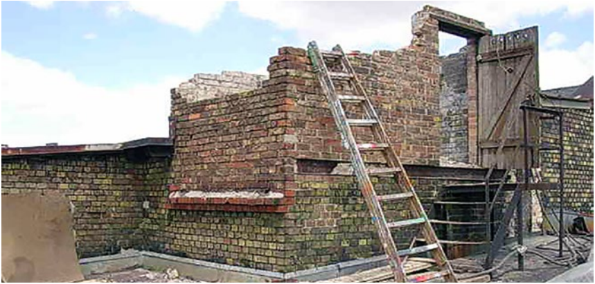
Abriss des des Dachaufbaus auf Haus C – Platz schaffen für den Lastenaufzug, 2004
