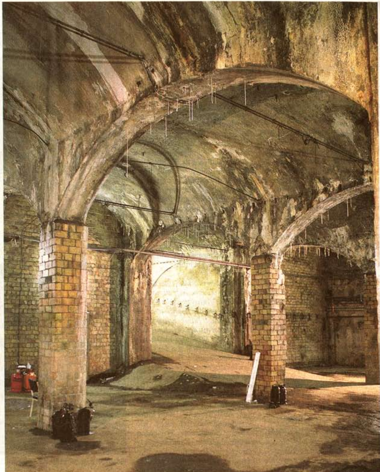
Ein Stück Brauerei-Geschichte: Kellergewölbe der alten Königstadt-Brauerei
